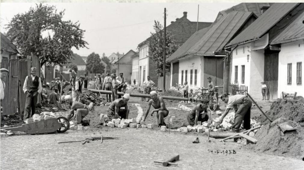
BUDOVÁNÍ NOVÉ CESTY. Dláždění silnice na Zábrani v okolí domu fotografa Františka Němečka v roce 1938.
